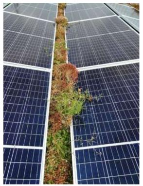
Eine PV-Anlage auf einem begrünten Dach – das geht, macht aber Mühe. Hoher und sich ausbreitender Bewuchs verschmutzt und verschattet die Module. Hinzu kommt, dass immer das schlechteste Modul den Arbeitspunkt eines Strings bestimmt, so dass ein einziges verschmutztes Modul den Wirkungsgrad einer ganzen Kette herabsetzt. Also gehört die regelmäßige Dachputzete zum Betrieb einer Gründachanlage.
